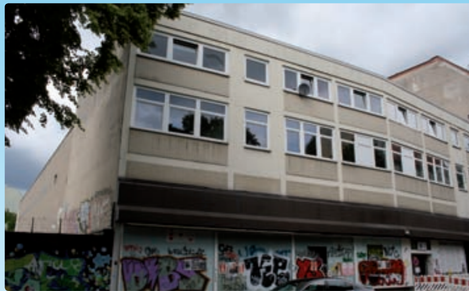
Außenansicht der Böhmisches Straße 53/54 - Bald starten die Bauarbeiten
