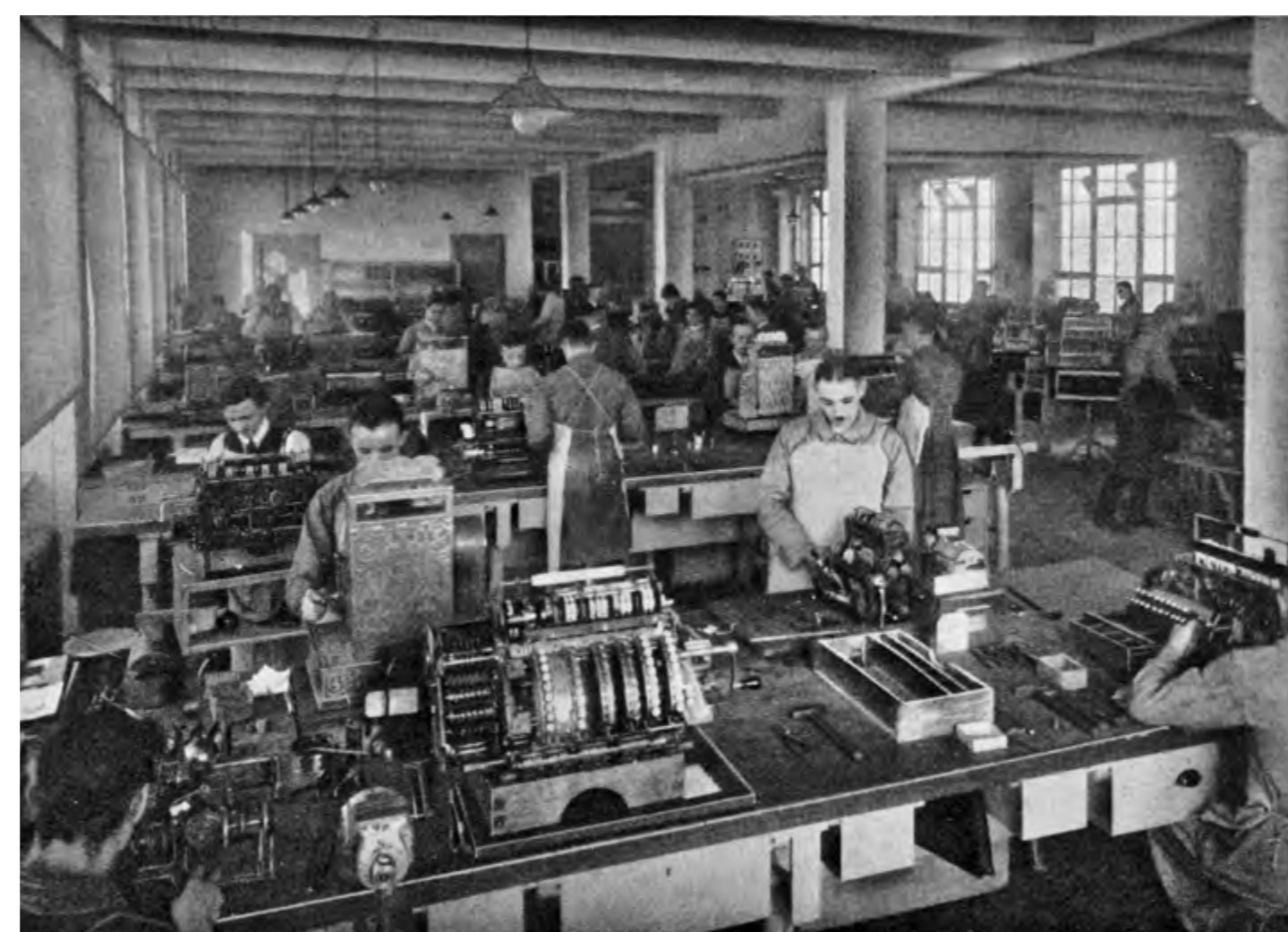
▲ Teilsicht der Kassenmontage, ca. 1930 (aus: Unsere Fabrikanlagen, Berlin Neukölln, Firmenprospekt der NRK, o.o., o.J.)
